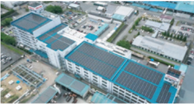
太陽光発電システム (オンサイトPPA) を導入した株式会社ミマキエンジニアリング加沢工場
