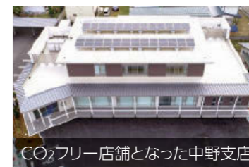
長野県内6店舗で県内の水力発電所でつくられたCO 2 フリー電力の利用を開始しました。
