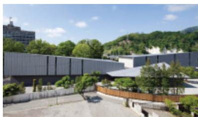
新研修所（平成26年4月竣工）：長野県産カラマツを利用。自然採光・クールヒートトレンチ（年間を通じて温度の安定した地中の熱を利用する仕組み）・Low-Eガラス・LED照明を採用
