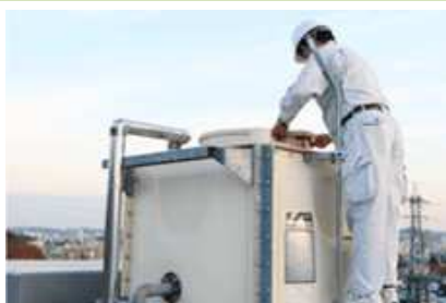
設備メンテナンス(給水装置)
