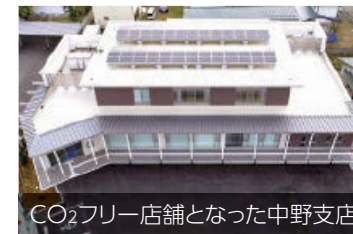
CO 2 フリー店舗となった中野支店 長野県内6店舗で県内の水力発電所でつくられたCO 2 フリー電力の利用を開始しました。
