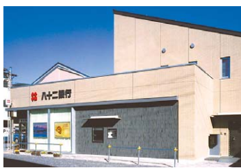
茅野駅前支店(平成20年11月新築移転):太陽光発電システム・外断熱工法採用のエコロジー店舗
