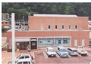
小海支店(平成18年1月新築移転):長野県内金融機関で初めての太陽光発電システム導入店舗
