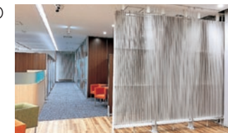
大町支店 地中熱ヒートポンプシステム
