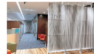
地中熱輻射パネル
